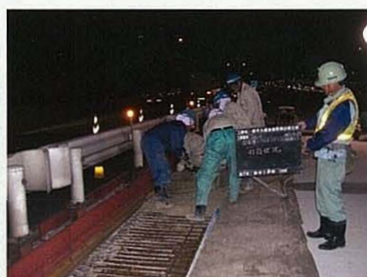
実施工での打ち込み状況
