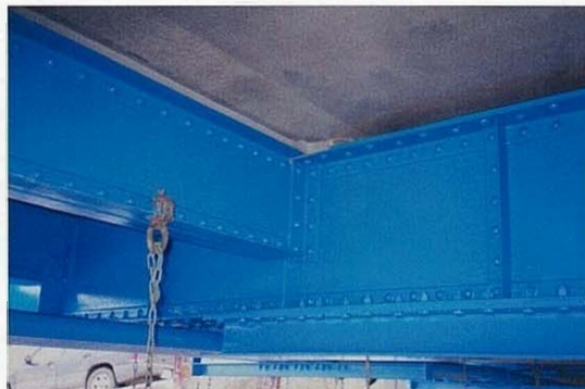
補強完了後
