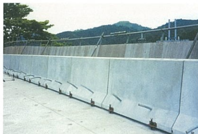
プレキャスト壁高欄の設置後の状況
