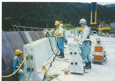
PC鋼材の緊張
