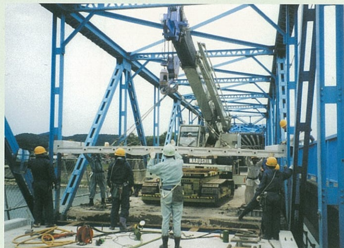
II期施工 [主桁増設・床版取替え・高欄設置]
