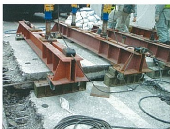
④ 床版はがし
