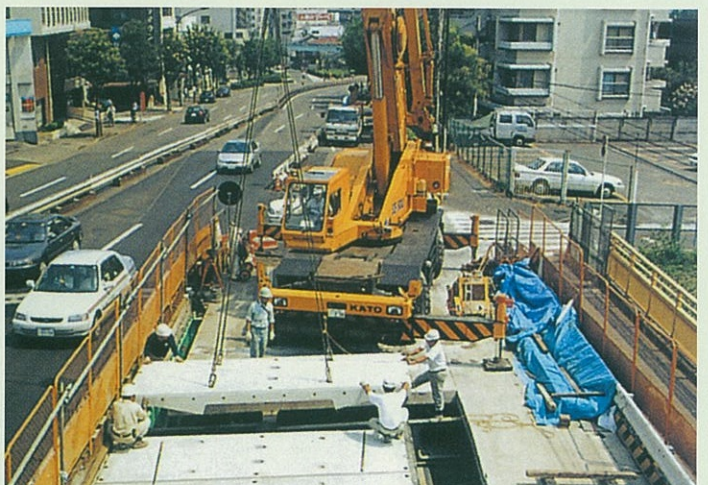
橋梁名：田園調布橋／発注者：東京都
