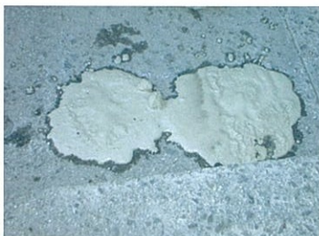
② 破碎剤の注入
