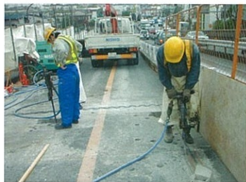
① 注入用孔あけ
