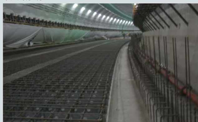
中央環状線シールドトンネル
