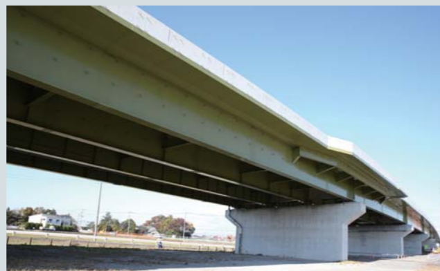
幸手地区高架橋
