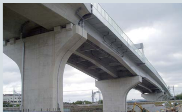
長岡京第1高架橋
