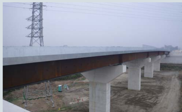
相川北高架橋
