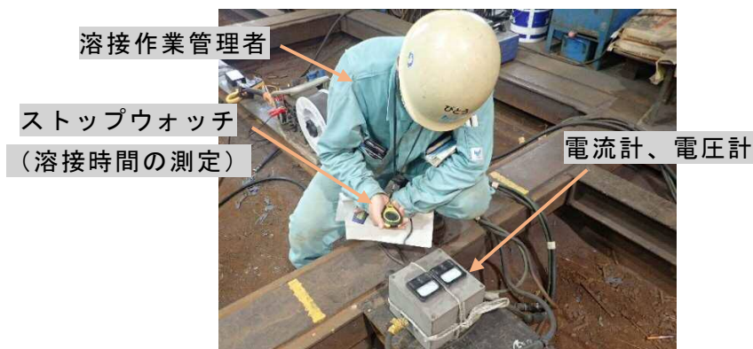
写真1 一般的な溶接管理の様子
