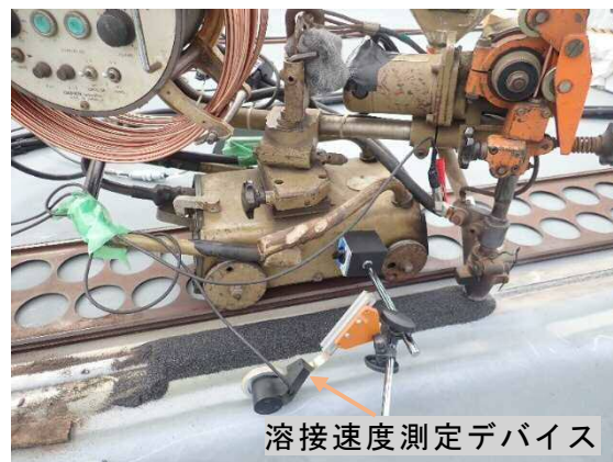
(c) サブマージアーク溶接（現場溶接）
