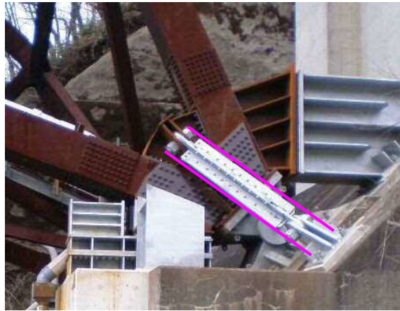
上路アーチ橋支点部【新設】
