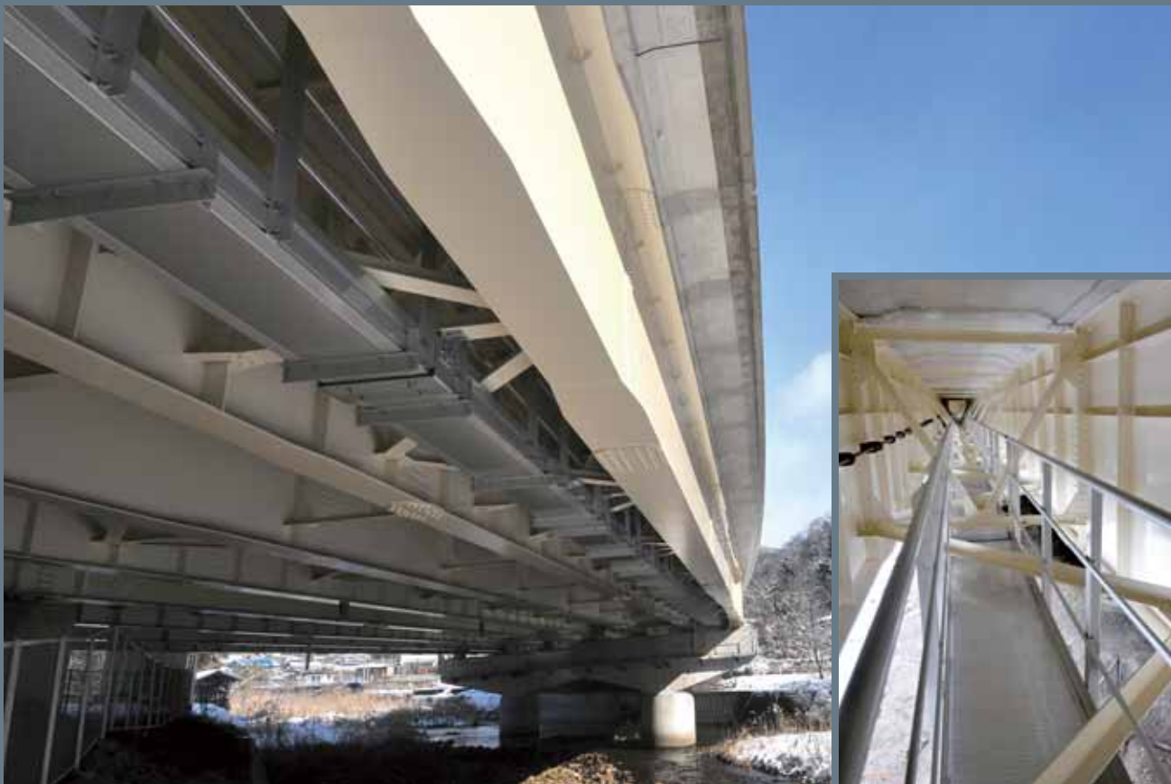
件名：下熊谷橋 施主：西日本高速道路株式会社 場所：岡山県新見市
