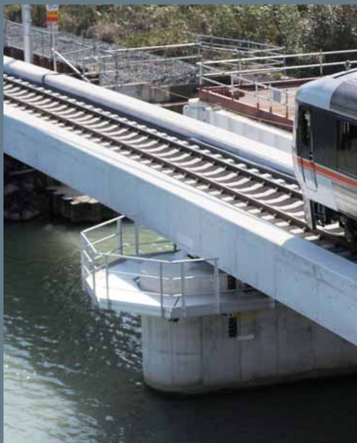
件名：那智川橋りょう 施主：西日本旅客鉄道株式会社 場所：和歌山県那智勝浦町
