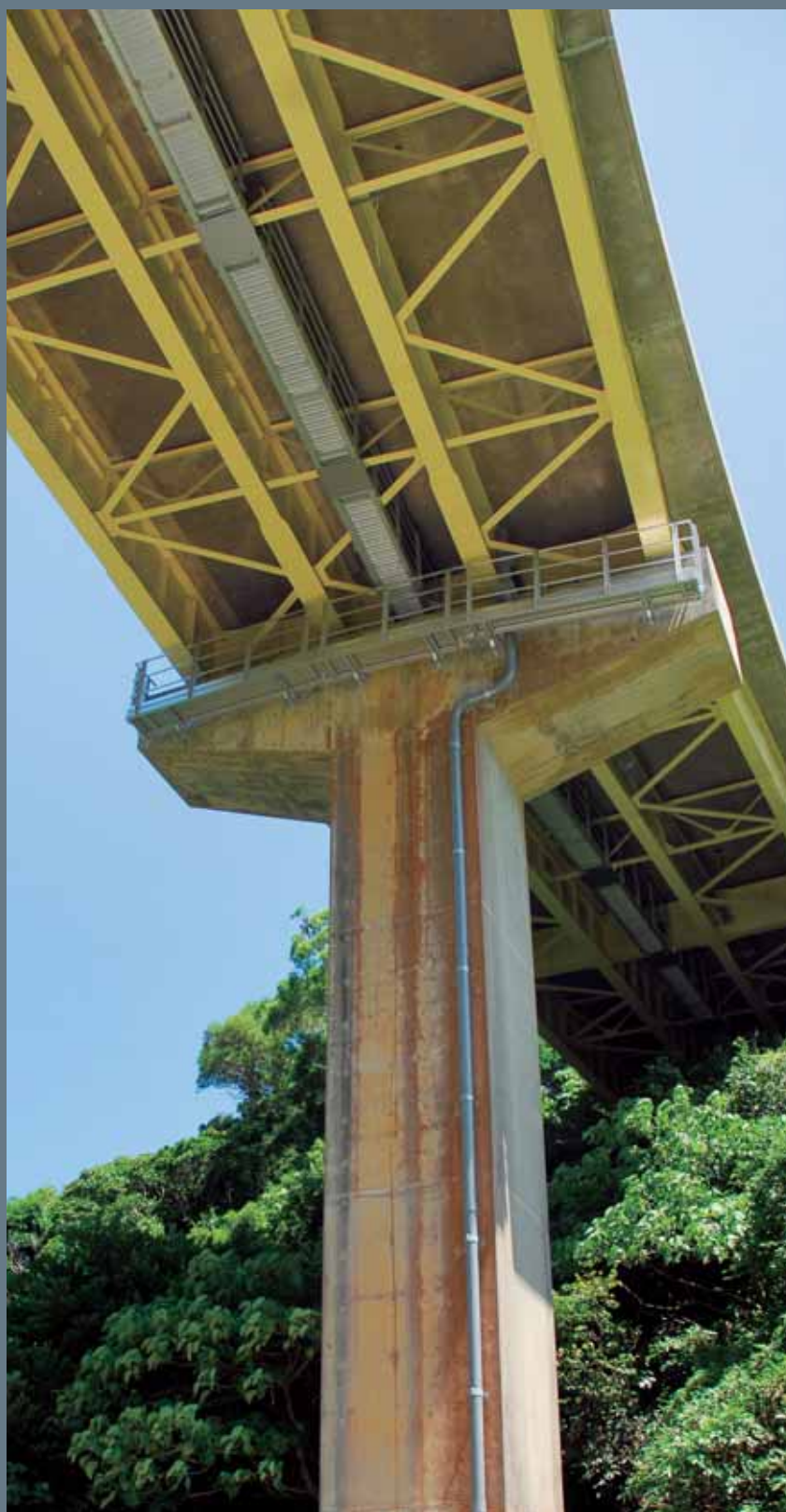
件名：たまた橋 施主：沖縄県北部土木事務所 場所：沖縄県国頭郡
