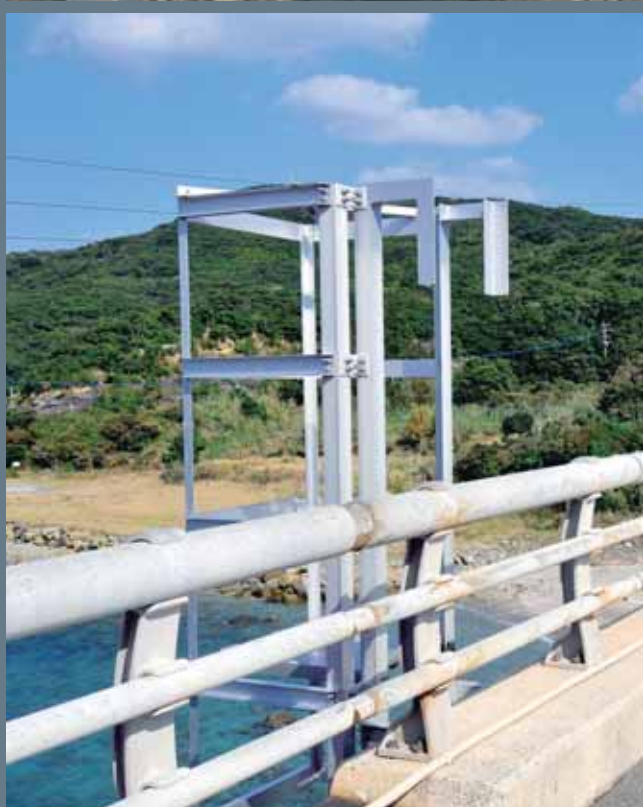
件名：頭ヶ島大橋 施主：五島振興局上五島支所 場所：長崎県南松浦郡
