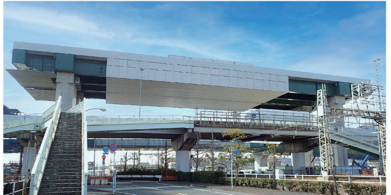
城陽第二高架橋/京都府 新設橋に設置
