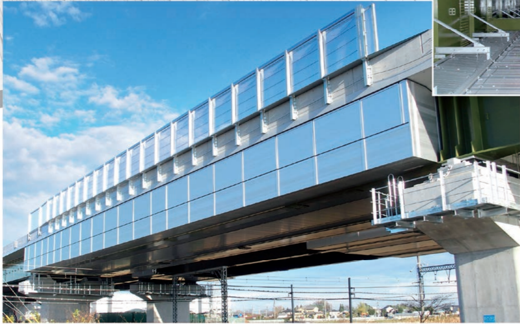
下万田第二高架橋II期線/埼玉県 新設橋に設置
