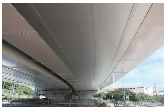
北丘高架橋（下り）／沖縄県 新設橋に設置
