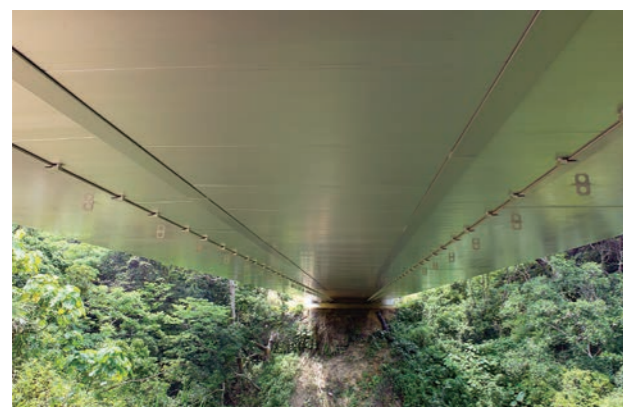
ヒチャンガーラ橋／沖縄県 新設橋に設置
