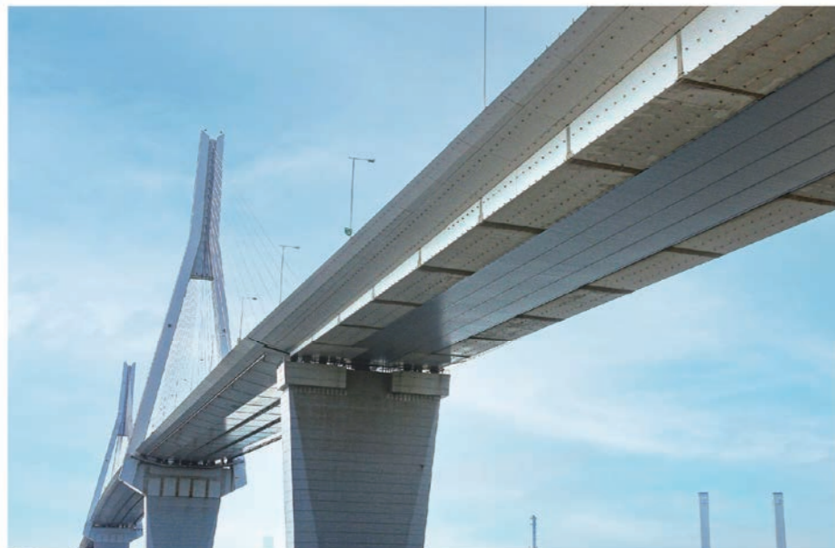
鶴見つばさ橋隣接部／神奈川県 既設橋に設置
