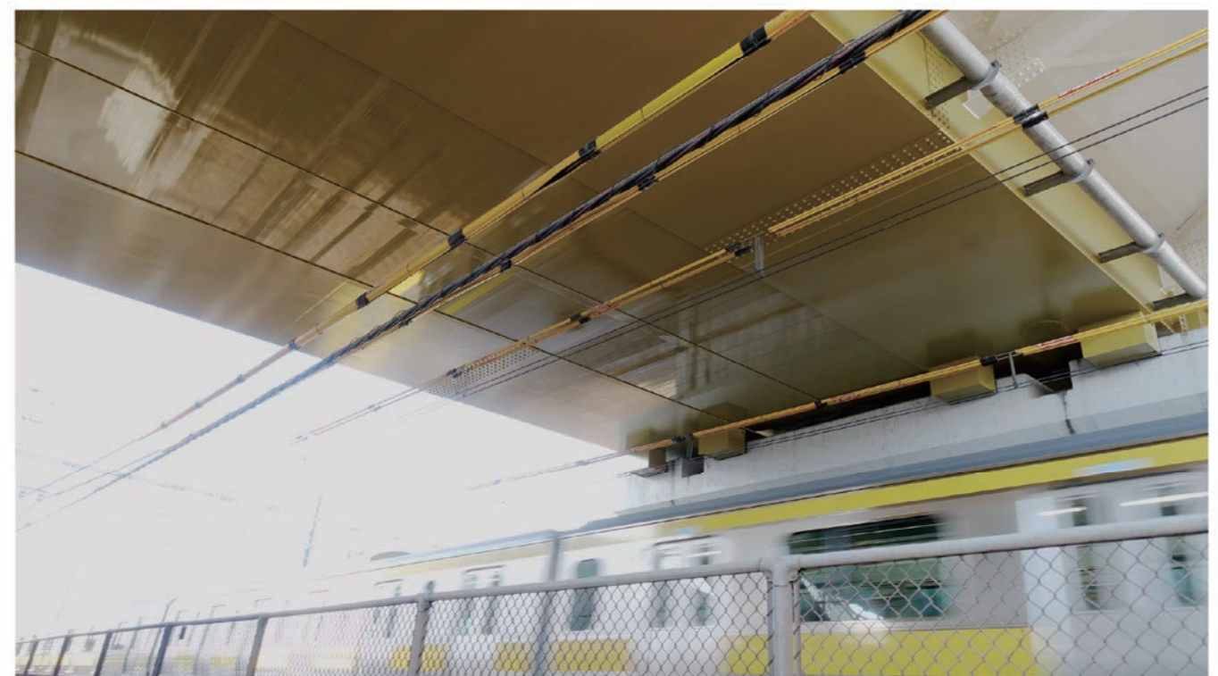
小松橋／東京都 既設橋に設置
