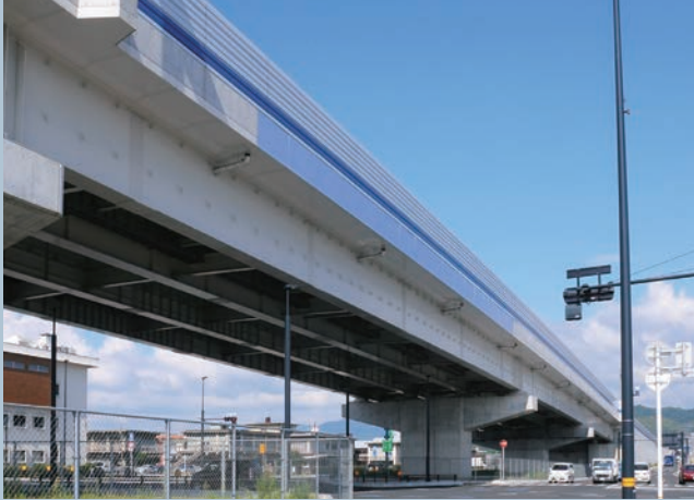
高速3号線 観音西工区：広島高速道路公社
