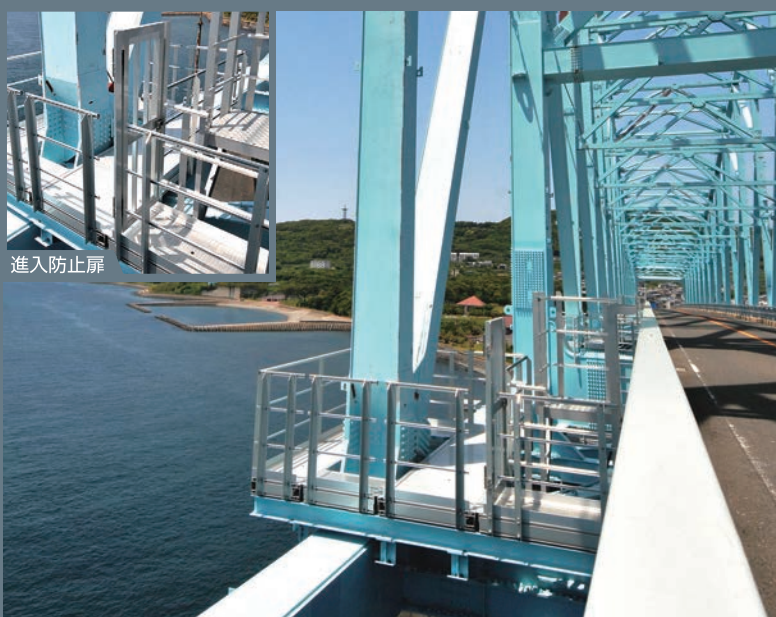
件名：生月大橋 施主：長崎県北振興局 場所：長崎県平戸市
