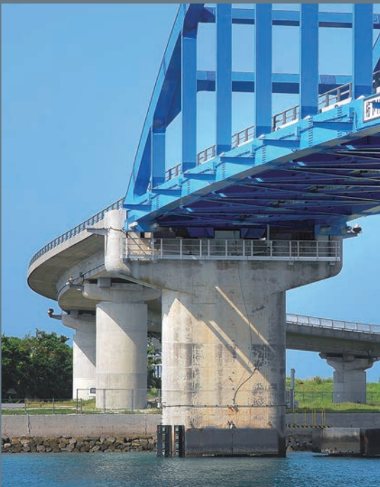
件名：サザンゲートブリッジ 施主：石垣市役所 場所：沖縄県石垣市
