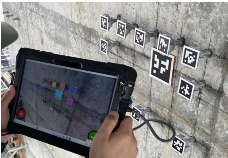
【現場計測状況イメージ】
